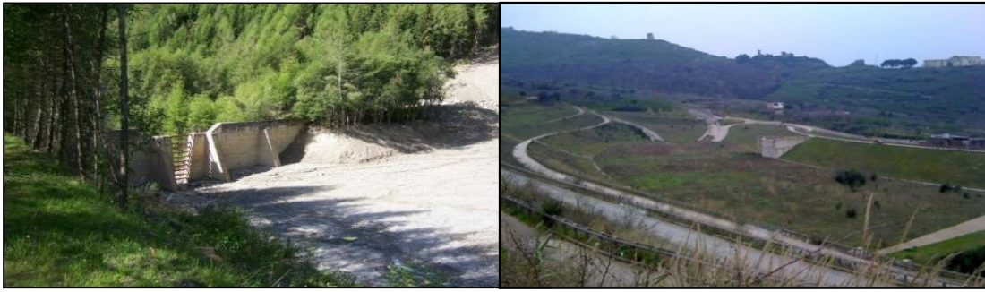
Figura 75. Ejemplos de obras de mitigación para la retención de la porción sólida transportada por un lahar: a) trampa de sedimentación y b) alberca de sedimentación en el volcán Vesubio (Sarno, Italia).
